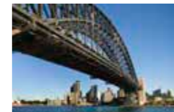
Korrosionsschutzschichten in rauen Umgebungen
